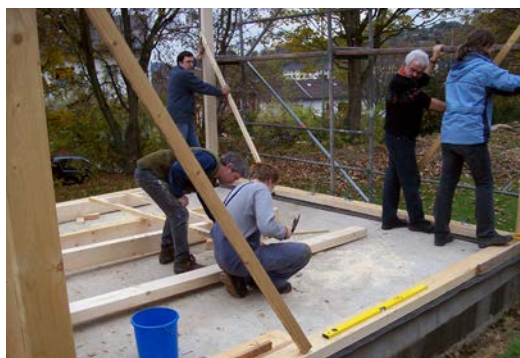
Bau eines sog. Gipfelhauses als Rückzugsraum für Streitschlichtung (Pestalozzi-Schule Siegen)
